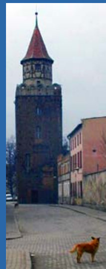
Von der Stadtbefestigung in Chojnow (Haynau) ist der „Weberturm“ erhalten, der um das Jahr 1400 erbaut wurde.
